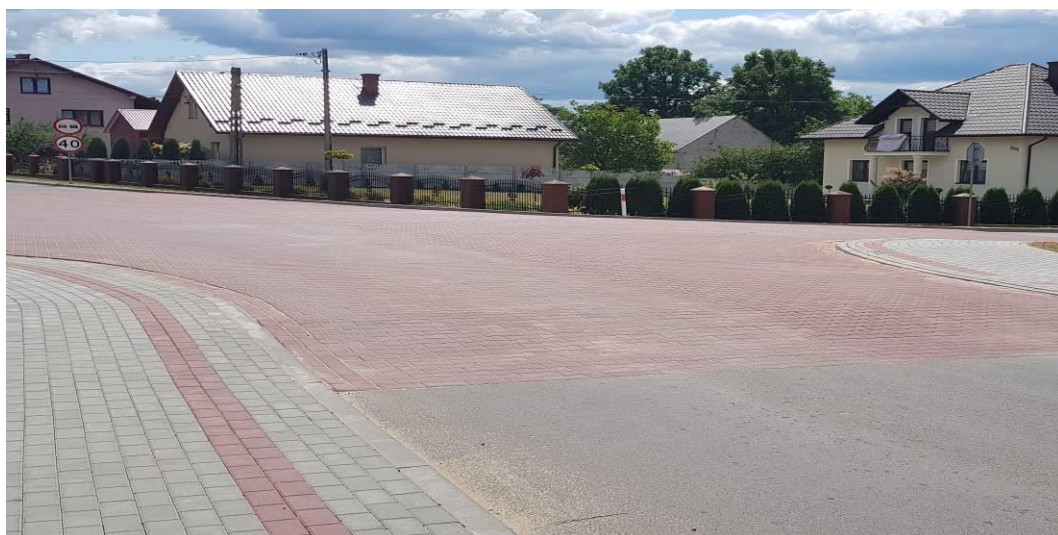
Fot. Droga powiatowa Nr 1277R Kamień-Łowisko-Wola Zarczycka po wykonaniu prac związanych z jej rozbudową
