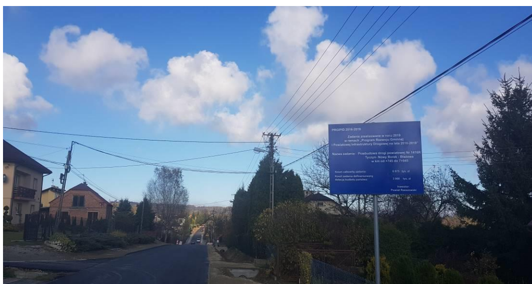
Fot. Droga powiatowa Nr 1416R Tyczyn – Nowy Borek – Błażowa w km od 0+745 do 7+947 po wykonaniu prac związanych z jej przebudową
