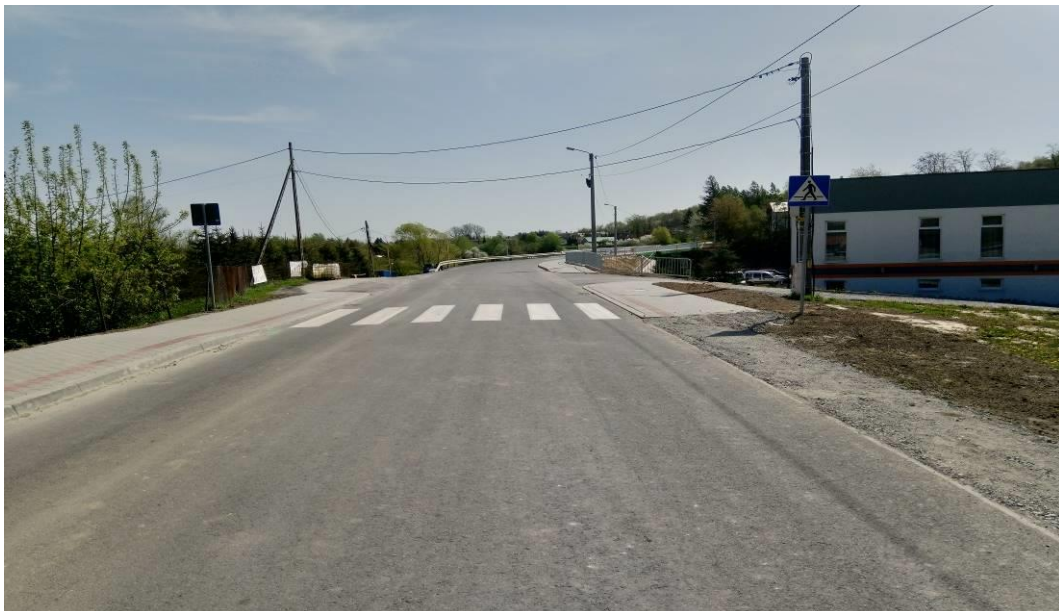
Fot. Most na rzece Wisłok wraz z dojazdami w ciągu drogi powiatowej Nr 1405R po wykonaniu prac związanych z jej rozbudową
