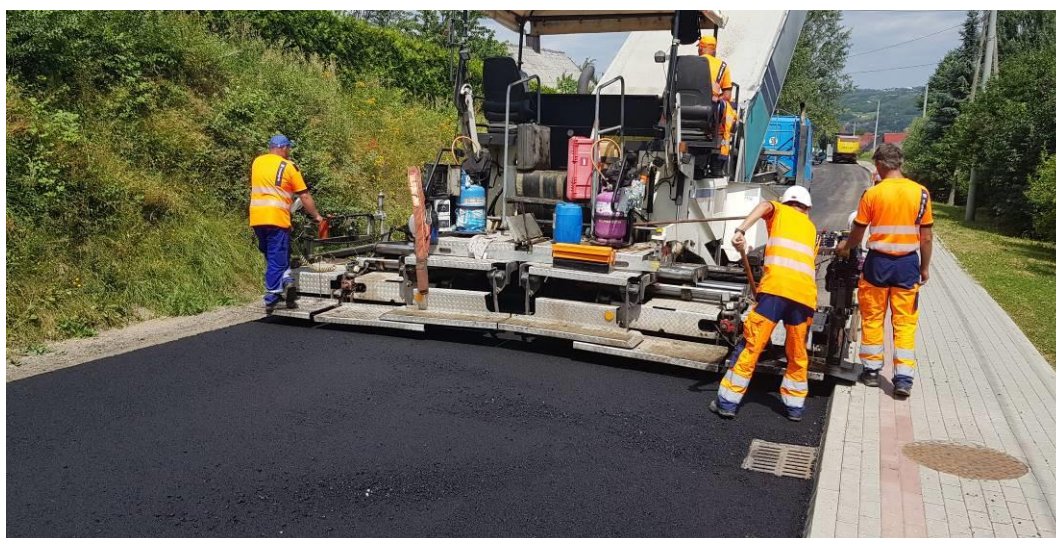
Fot. Prace budowlane wykonywane na drodze powiatowej Nr 1416R Tyczyn – Nowy Borek – Błażowa
