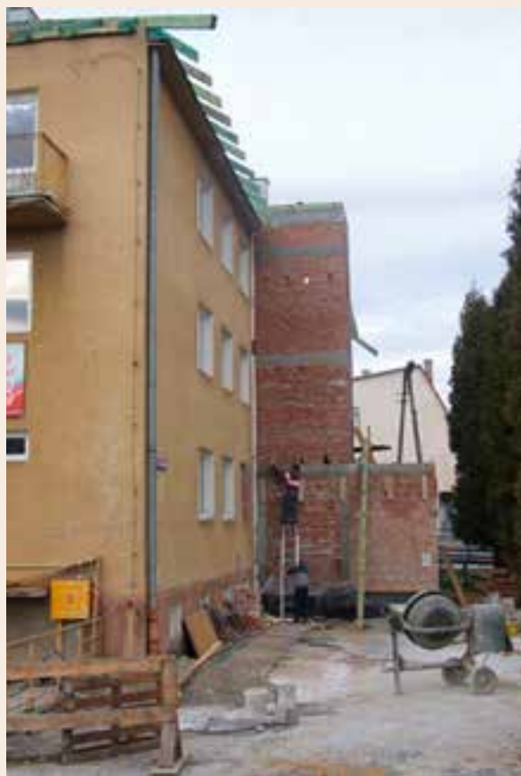
Przychodnia Rejonowa w Błażowej w trakcie inwestycji
