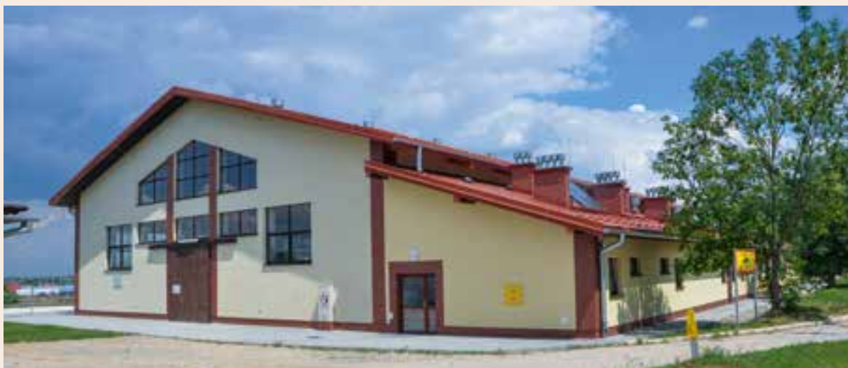
Rozbudowany maneż w Trzcianie
