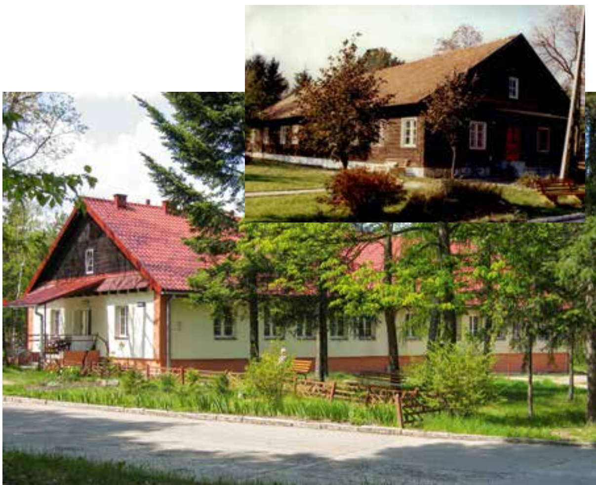
Kompleksowa termomodernizacja dziewięciu pawilonów Domu Pomocy Społecznej w Górnicy, w latach 2003–2004. Wartość zrealizowanego przedsięwzięcia to 1 mln 103 tys. zł (na zdjęciu jeden z obiektów przed realizacją inwestycji i po jej zakończeniu)
