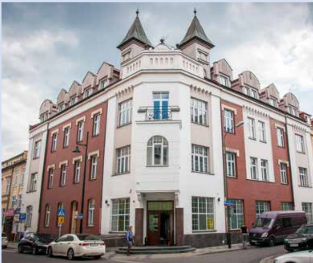
Budynek Starostwa Powiatowego w Rzeszowie przy ul. Bernardyńskiej 7 po gruntownej modernizacji. Kamienica pochodzi z 1903 roku. W odnowionym budynku mieści się Powiatowy Ośrodek Dokumentacji Geodezyjnej i Kartograficznej, który dotychczas miał swoją siedzibę w wynajmowanych pomieszczeniach przy ul. Targowej 1. Przedsięwzięcie to było jednym z działań mających na celu podniesienie standardów obsługi mieszkańców. Na parterze mieści się sala obsługi klienta. W budynku jest także sala sesyjna Rady Powiatu Rzeszowskiego. Remont wykonało konsorcjum firm: Przedsiębiorstwo Produkcyjno-Handlowo-Usługowe ITALIA z Malawy (lider) oraz HYDRO-MET Sp. z o.o. z Futomy. Uroczyste zakończenie tej inwestycji miało miejsce w dniu 10.09.2019 r. Dokonano wtedy także odświeżenia tablicy upamiętniającej 100-lecie odzyskania niepodległości przez Polskę.
