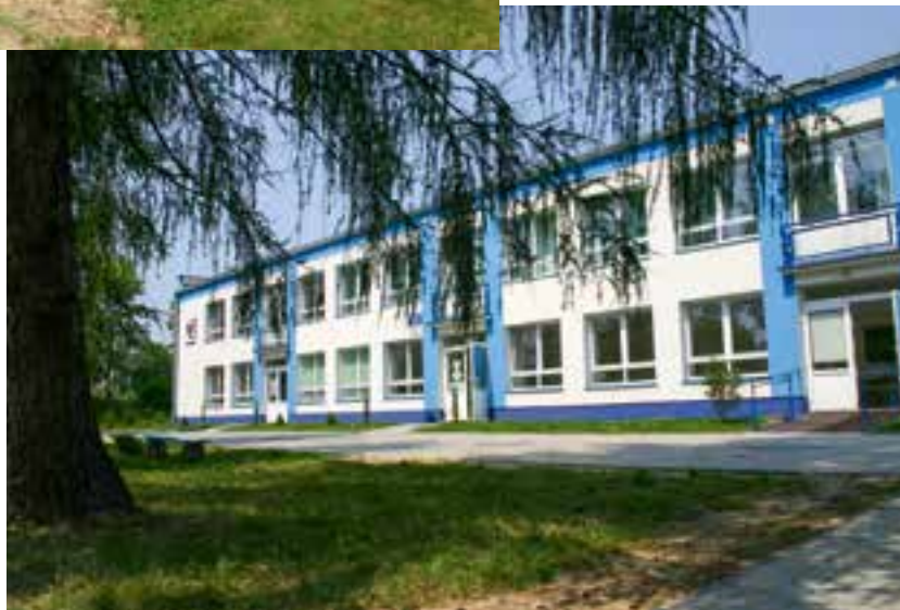
Adaptacja budynku Przychodni Rejonowej w Dynowie na Zakład Opieki Długoterminowej w latach 2000–2001. Wartość inwestycji wyniosła 1,5 mln zł
