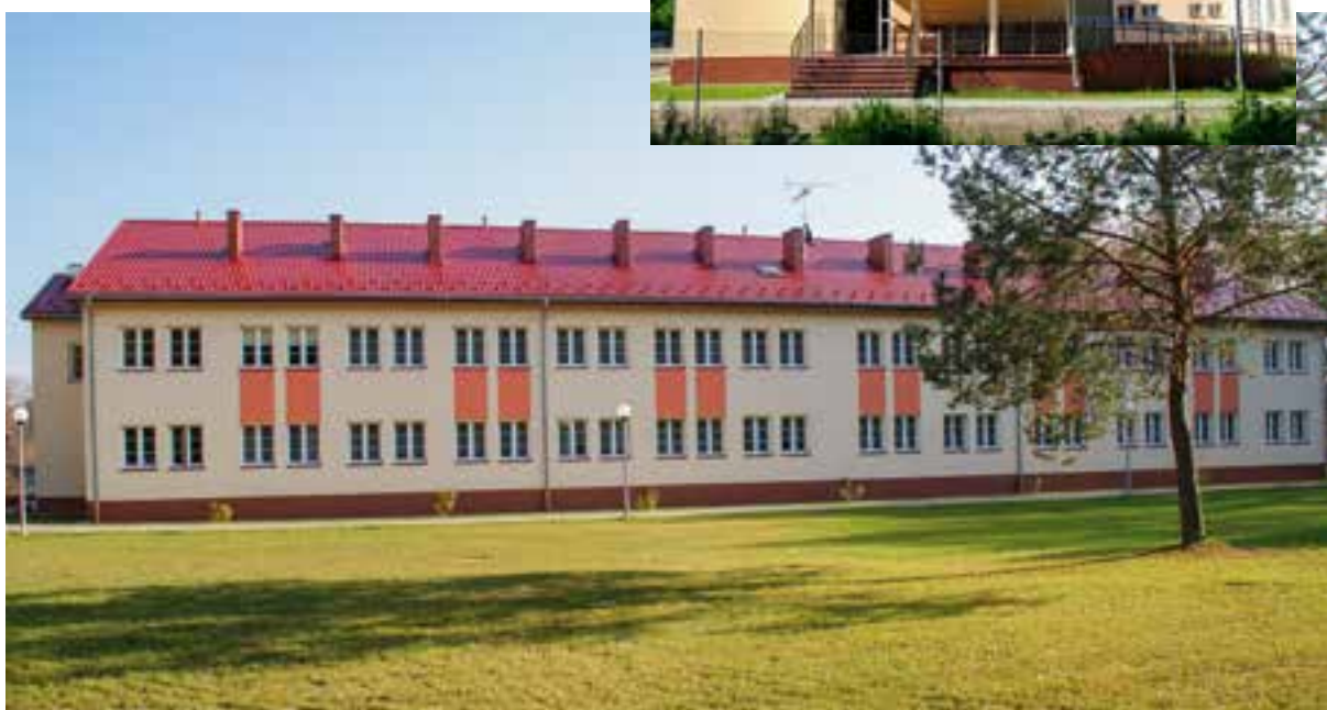
Rozbudowa Domu Pomocy Społecznej w Górnicy o dwukondygnacyjny budynek z przewiązką, zakończona w 2011 r.
