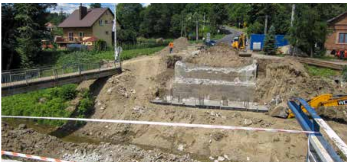
Budowa innowacyjnego mostu w Błążowej
