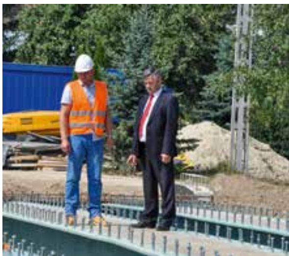
Budowa innowacyjnego mostu w Błażowej
