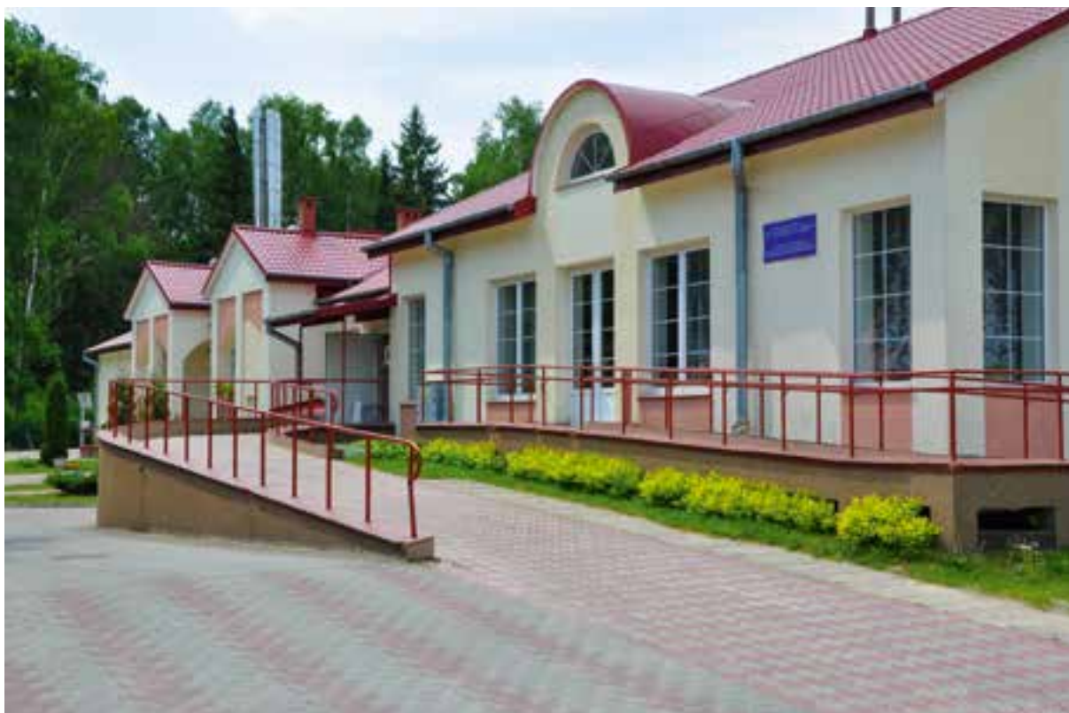
Budowa Centrum Rehabilitacyjno-Socjalnego przy Domu Pomocy Społecznej w Górnicy, w latach 1998–2001
