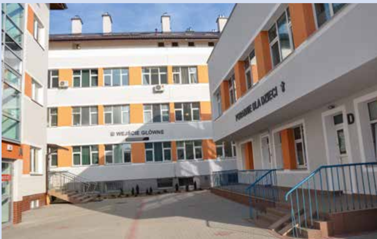
Przychodnia Specjalistyczna – Centrum Diagnostyczne w Rzeszowie po zakończeniu inwestycji
