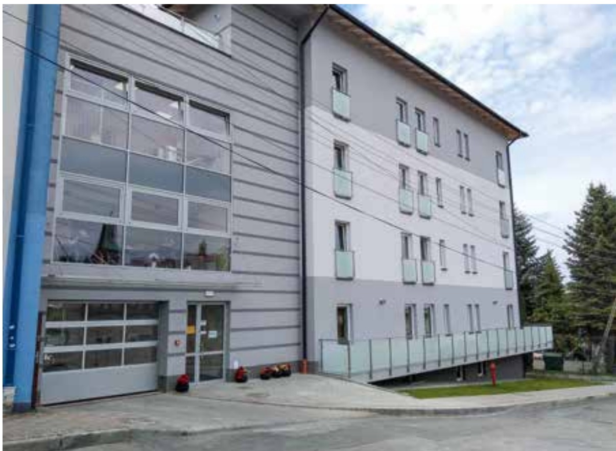
Zakład Opieki Długoterminowej i Paliacji w Błazowej po zakończeniu inwestycji
