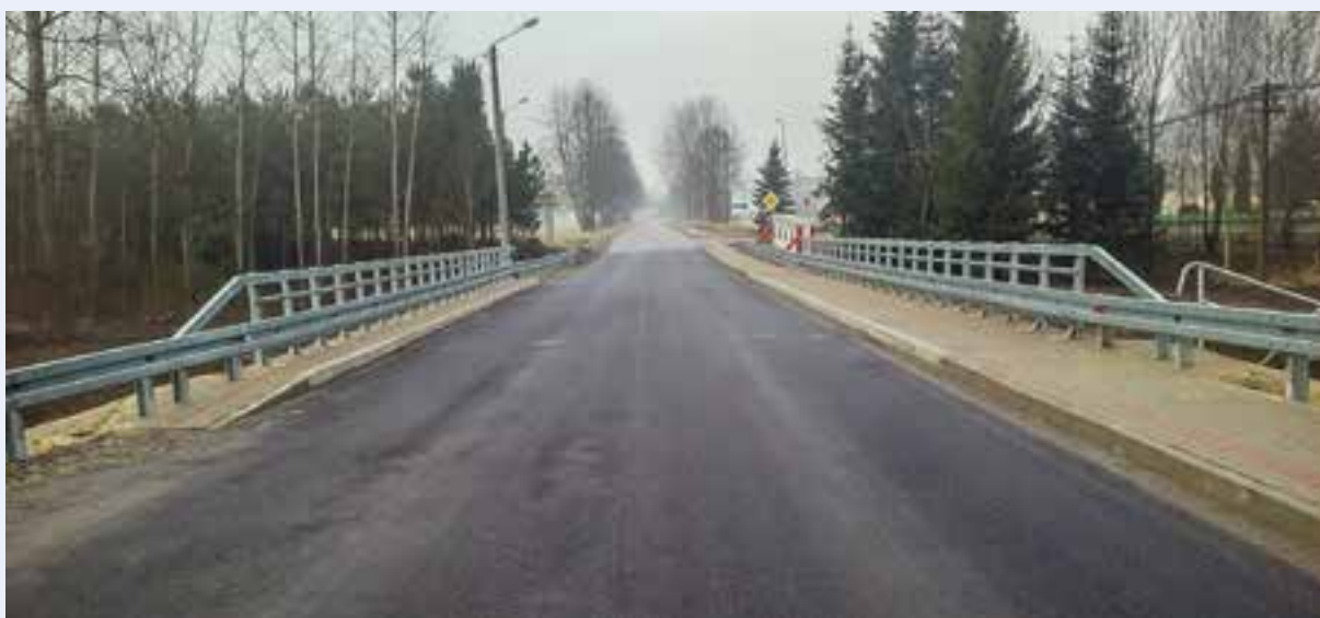
Przy moście została zachowana belka kratownicowa żelbetowa ze starego obiektu, jako pomnik myśli technicznej
